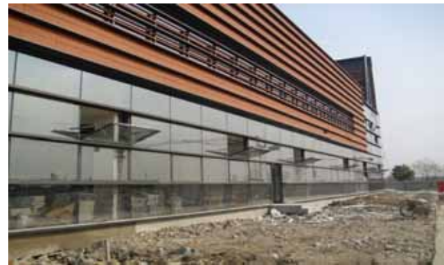
产品名称：气动排烟窗设备（压缩空气气源） 驱动设备：气缸，压缩空气气源（空压机+储气罐），消防联动+日常通风 管道系统：热镀锌钢管
