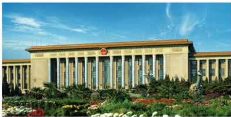
人民大会堂 门窗改造工程
