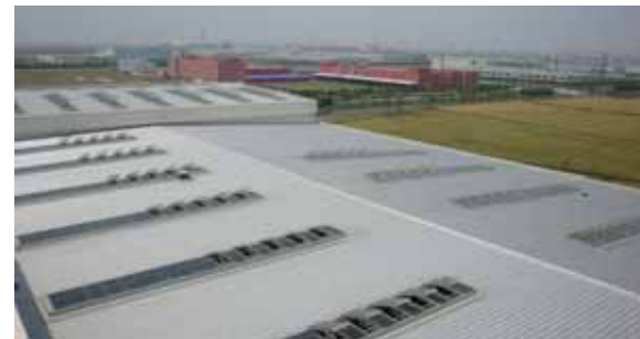
产品名称：电动排烟天窗（一字单开型） 窗体性能：铝合金窗体（粉末喷涂），6+0.76pvb+6钢化夹胶玻璃 驱动设备：电动开窗器，消防联动+日常通风 注：面板也可配置聚碳酸酯板、铝板
