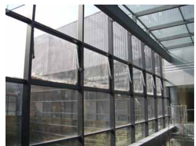
气动排烟侧窗：中国商用飞机有限公司 大型客机综合试验厂房
