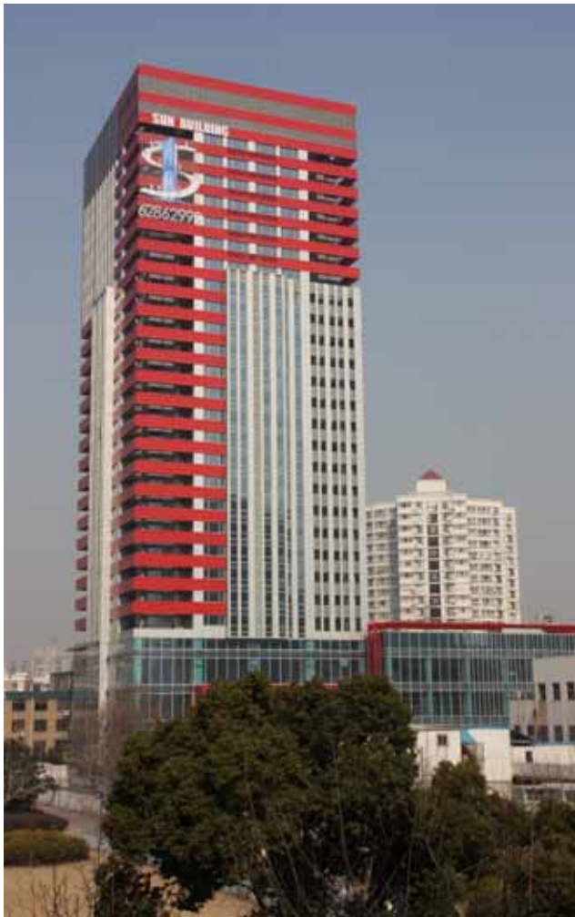
上海汇华大厦
